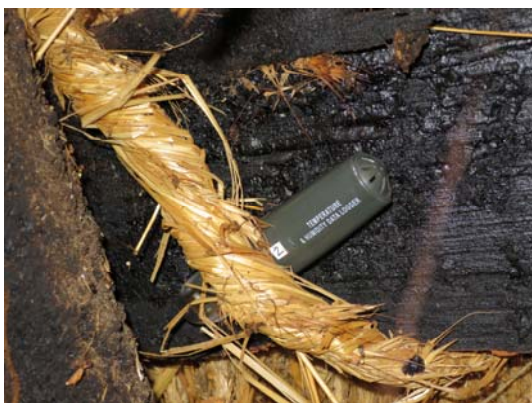
Registro "data logger" de t^a y humedad
